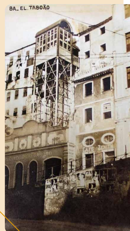
Figuras 1, 2, 3, 4 e 5: Foto histórica (esq.), abandono, rampa acesso, panorâmica e aérea/sítio
