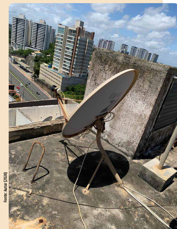
Foto 02: Base da antena sem interligação com o sistema de captação. Fonte: Autor (2024)
